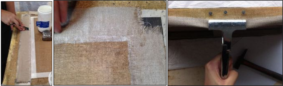
Pose des bandes de tension ©CB
