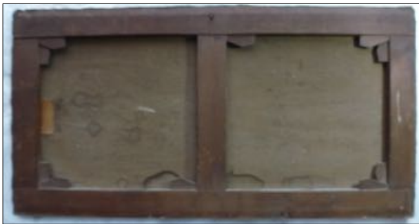
Châssis avant intervention
