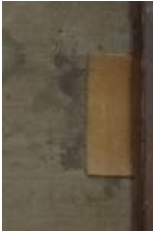
Planchette de bois faisant office de pièce, placée le long du montant dextre du châssis
