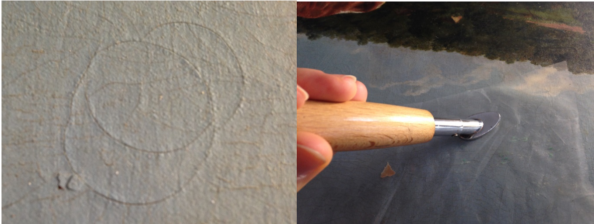
Traitement de ces petits soulèvements localisés ©CB
