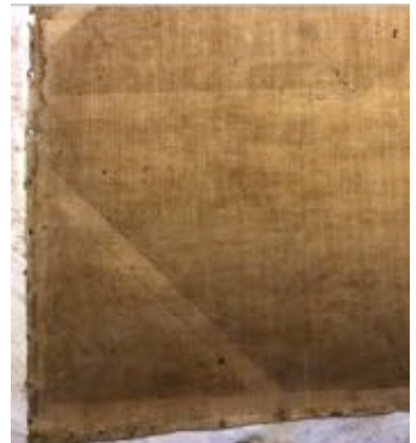
Marques au dos des deux traverses d'angle existantes. Trace d'une ancienne traverse verticale disparue, hypothèse d'un changement de châssis.
